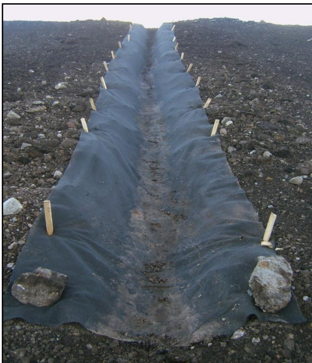
Figura 5. Vista de um canal instalado em talude com geotêxtil.
