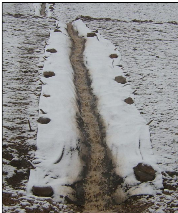
Figura 6. Vista de um canal em talude com geotêxtil em funcionamento durante o período de chuvas e presença de neve.
