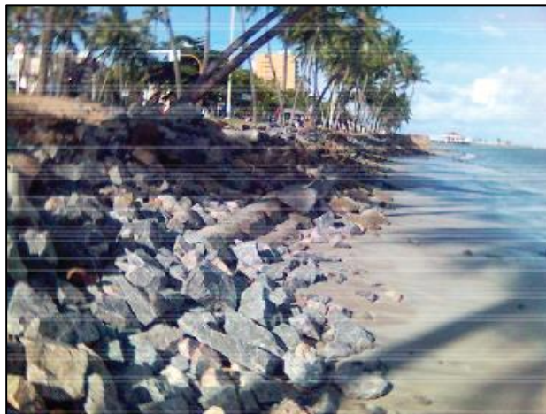
Figura 10. Controle de erosão com enrocamento. Fonte: Souza (2008)
