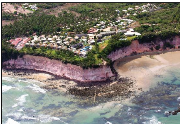
Figura 4. Edificações no topo de falésia em Pipa (RN). Fonte: Ronaldo Diniz
