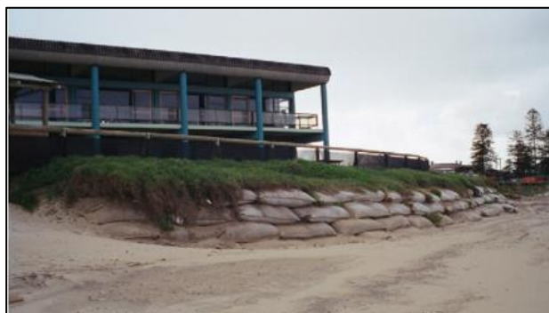
Figura 8. Utilização de geofôrmas na Praia de Stockton, Austrália.
